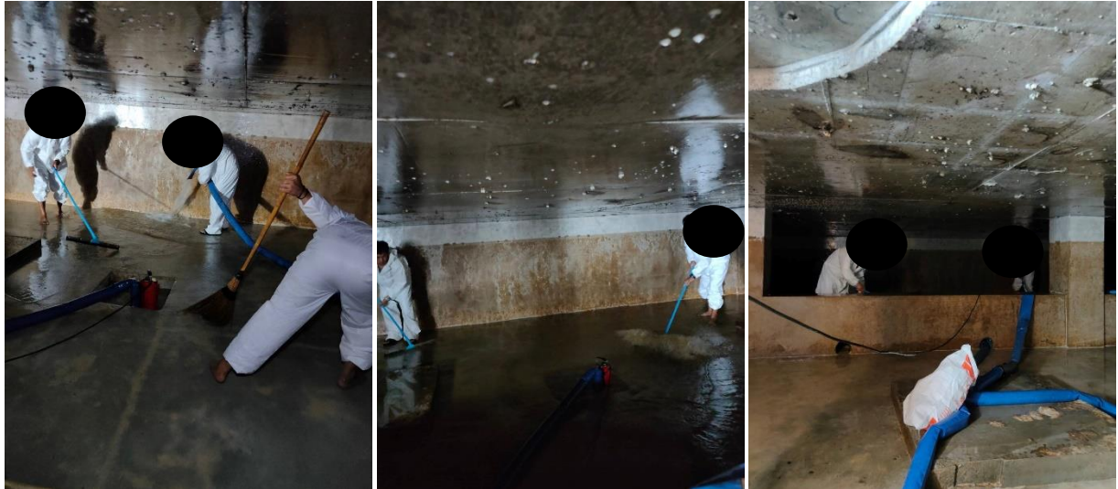
รูปที่ 2-32 ล้างทำความสะอาดถังเก็บน้ำ เมื่อวันที่ 21-23 พฤศจิกายน 2566
