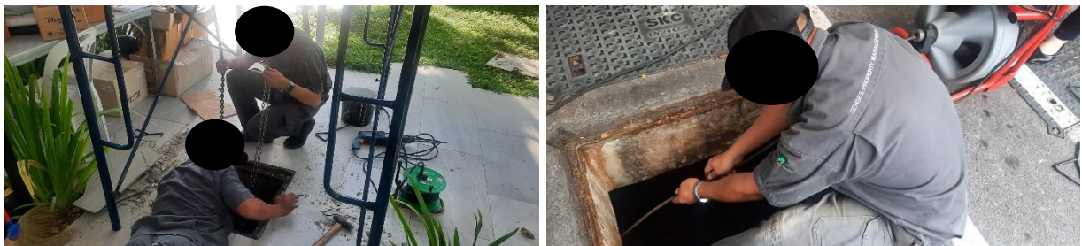
รูปที่ 2-33 ตรวจสอบและทำความสะอาดท่อระบายน้ำ
